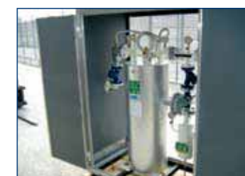
Ecovap 300A con gruppo di riduzione, in armadio coibentato. Ecovap 300A Vaporizer with pressure reduction assembly, in insulated cabinet.
